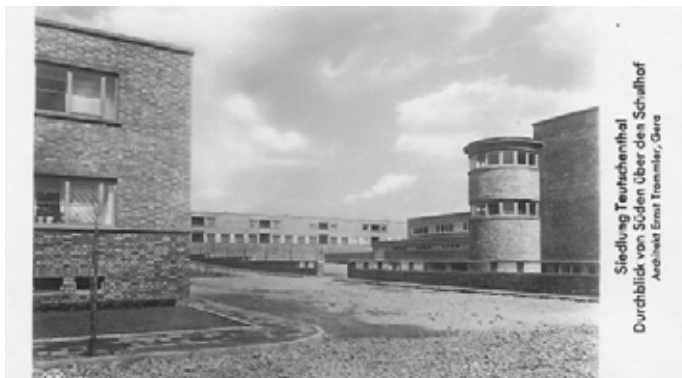
Abb. 2: „Siedlung Teutschenthal, Durchblick von Süden über den Schulhof“. Aufnahme von 1929. Bild: Leske 2016, S. 100
