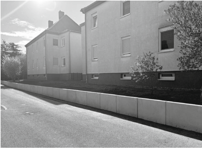
(Nach der Baumaßnahme. Foto: Ortsbürgermeisterin Martina Pretzsch)
