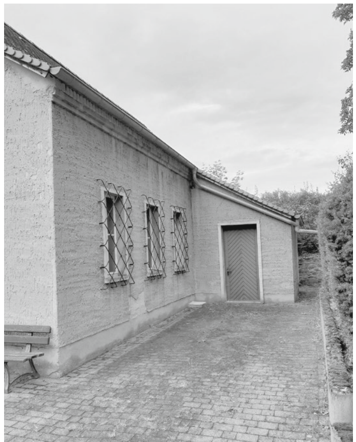
(Der rechte Nebenraum der alten Trauerhalle vor der Sanierung.)
