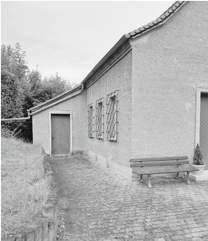
(Der linke Anbau der alten Trauerhalle vor der Sanierung.)
