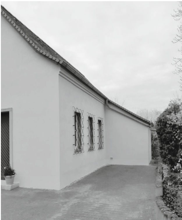
(Der rechte Nebenraum der alten Trauerhalle nach der Sanierung.)
