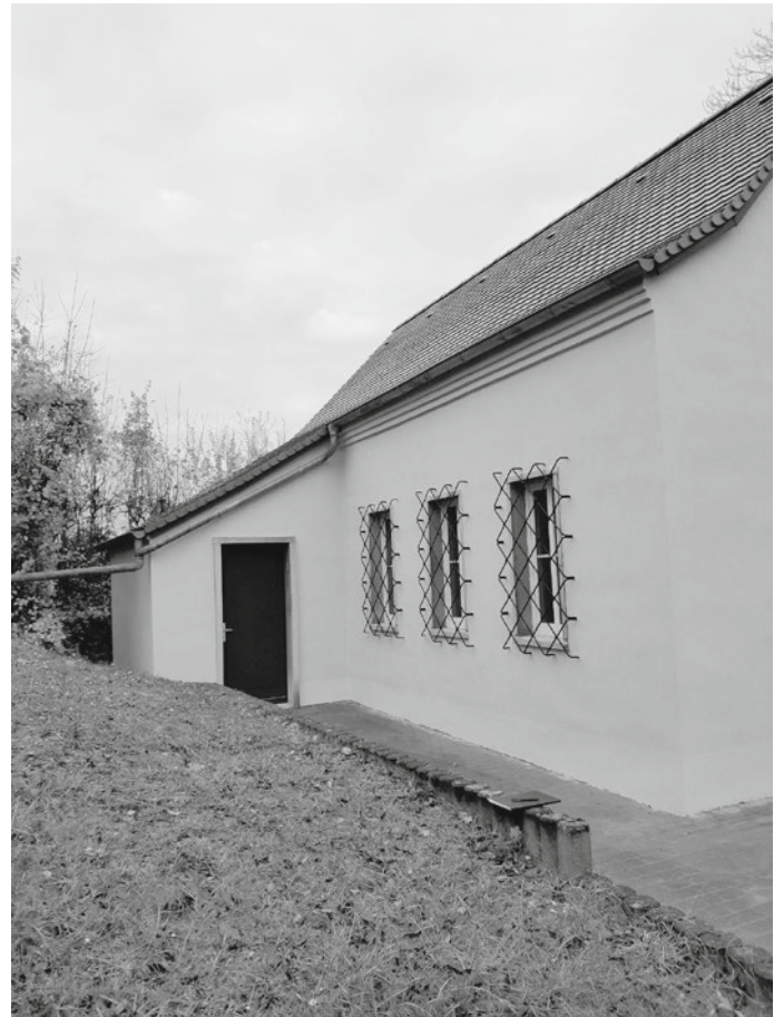
(Der linke Anbau der alten Trauerhalle nach der Sanierung.)
