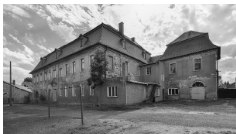
Abb. 1: Die Ostseite der Schlossanlage mit dem rechts angrenzenden Gartenpavillon. Foto: Anja Ulrich, Juli 2017
