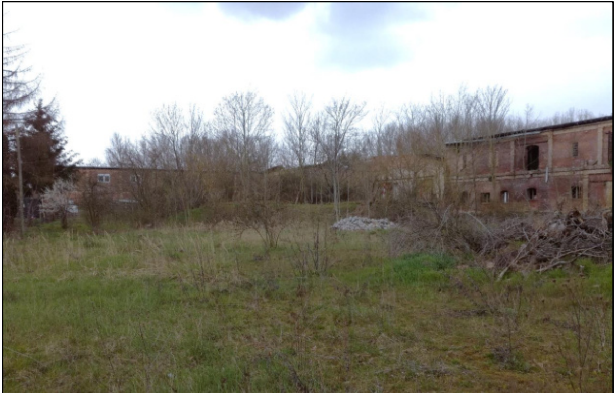
Abbildung 4-1: Blick nach Südwesten auf die Güllebecken, rechts im Bild Ablagerungen in Form von Bauschutt und Grünschnitt, im Hintergrund das ehemalige Stallgebäude (15.04.2021)
