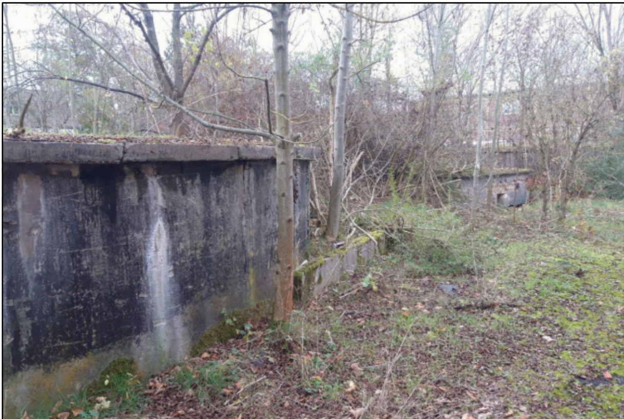
Abbildung 4-4: Blick in südlicher Richtung auf die zwei Güllebecken (07.11.2022)
