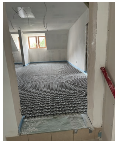
Baustelle Hort Holleben
