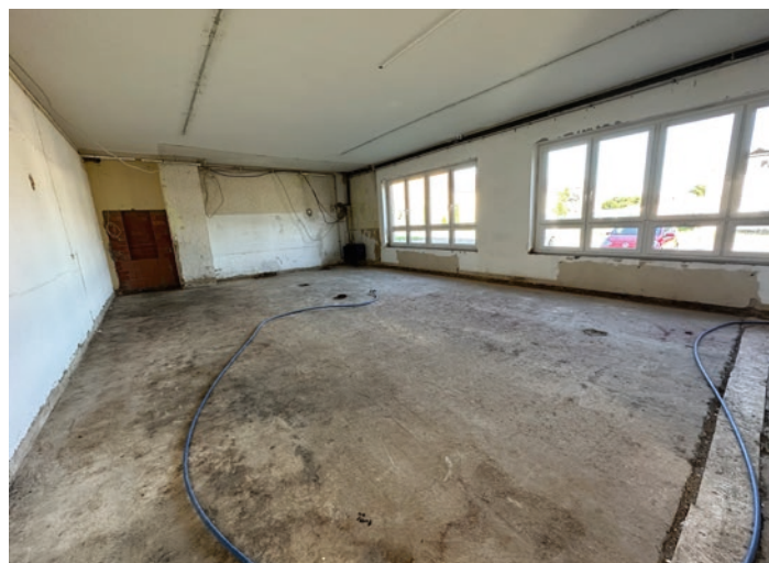
Baustelle Kita Dornstedt
