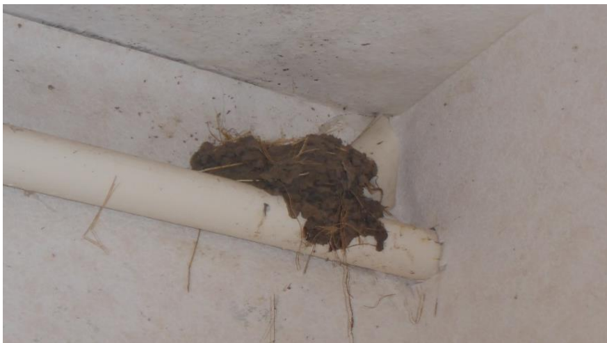
intaktes Schwalbennest in einem Wohnraum
