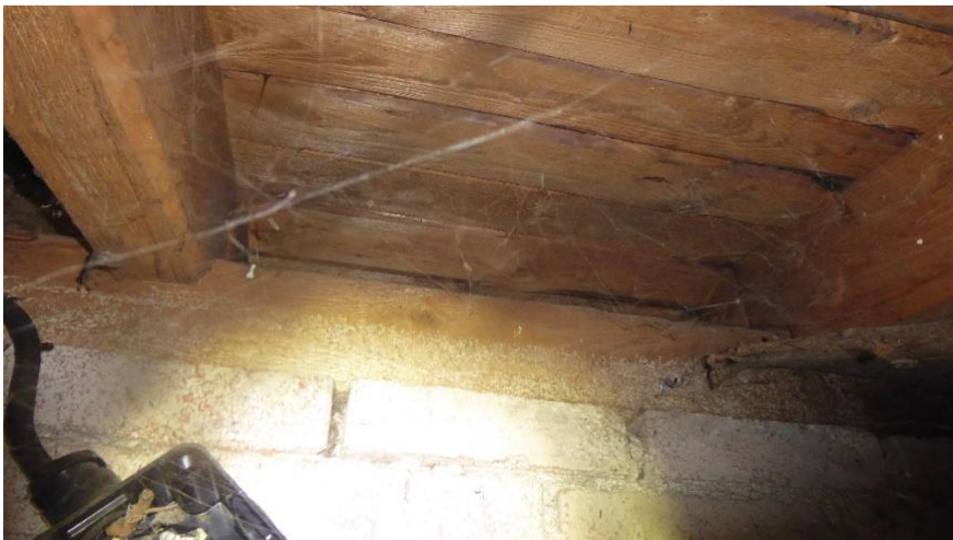
Spinnweben zwischen Dachbalken
