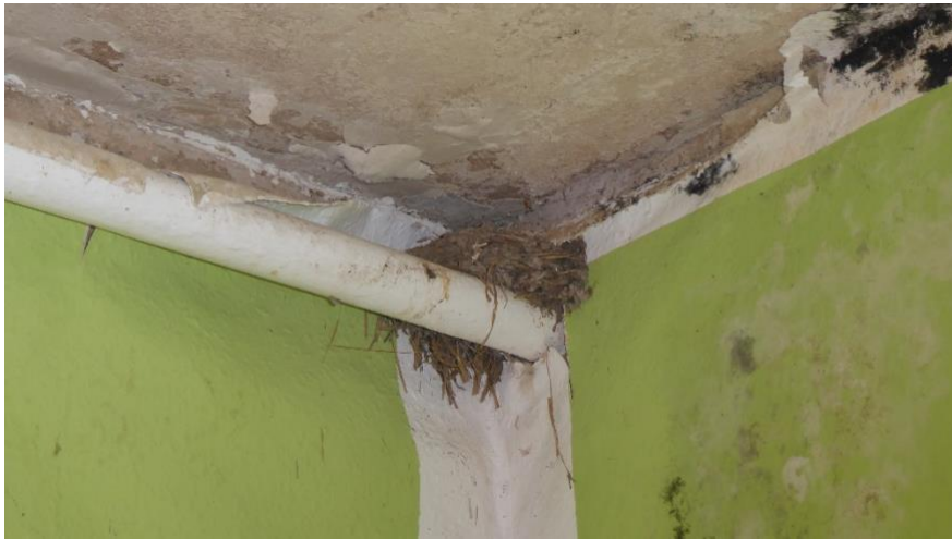
intaktes Schwalbennest in einem Wohnraum
