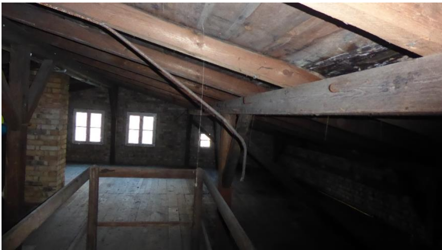
Dachboden mit Dachbalken
