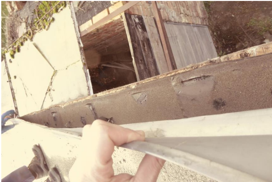
aufgebogene und anschließend entfernte Attika an der Westseite
