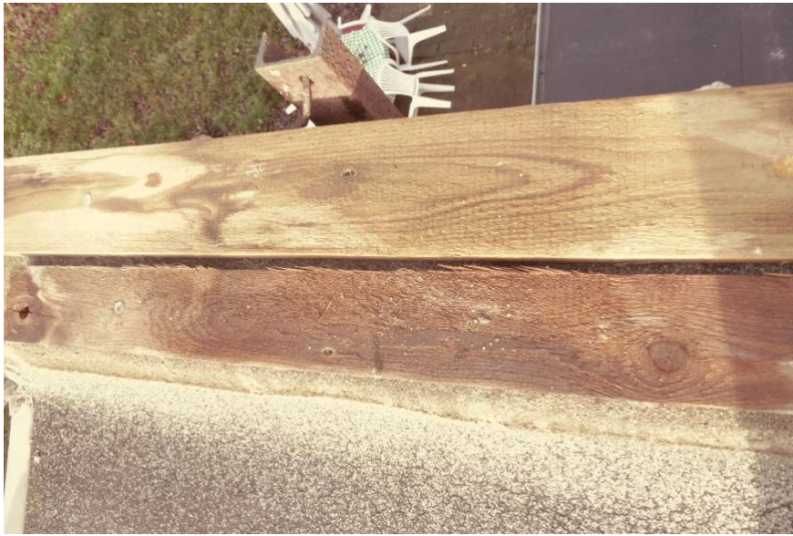
entfernte Attika an der Nordseite
