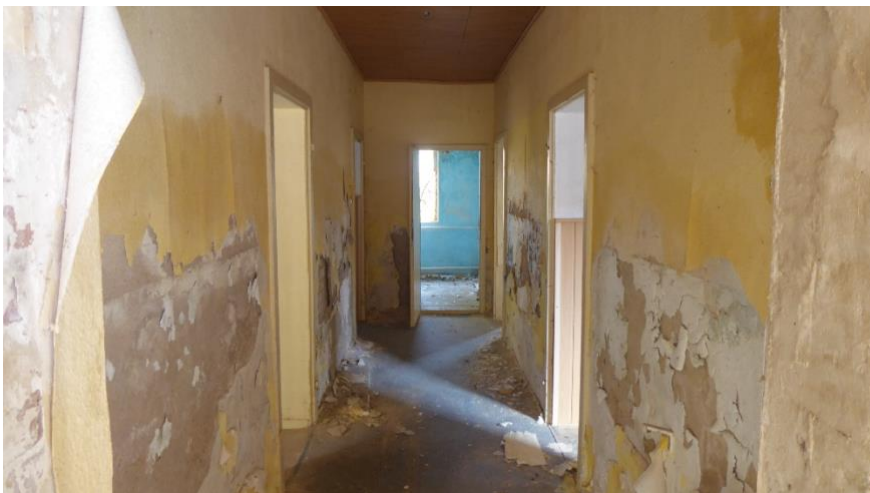
Innenraum (Flur), Lücke zum Dachboden verschlossen
