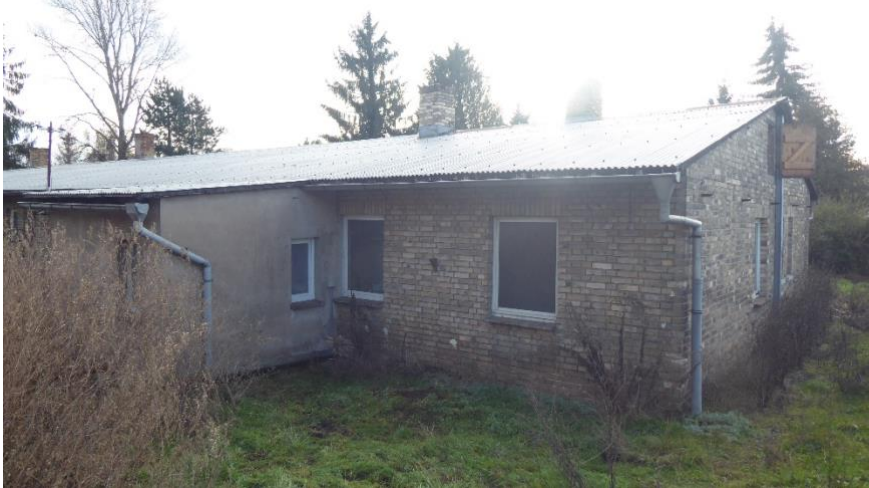
Nordseite mit Zugang zum Dachboden (offenstehende Holzluke)
