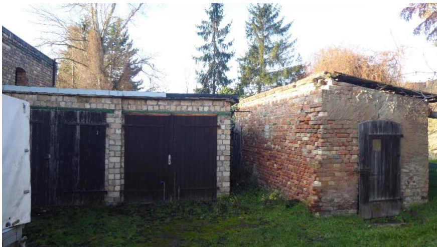
Frontansicht (Garagen und Schuppen jeweils noch in Nutzung, nicht zugänglich)
