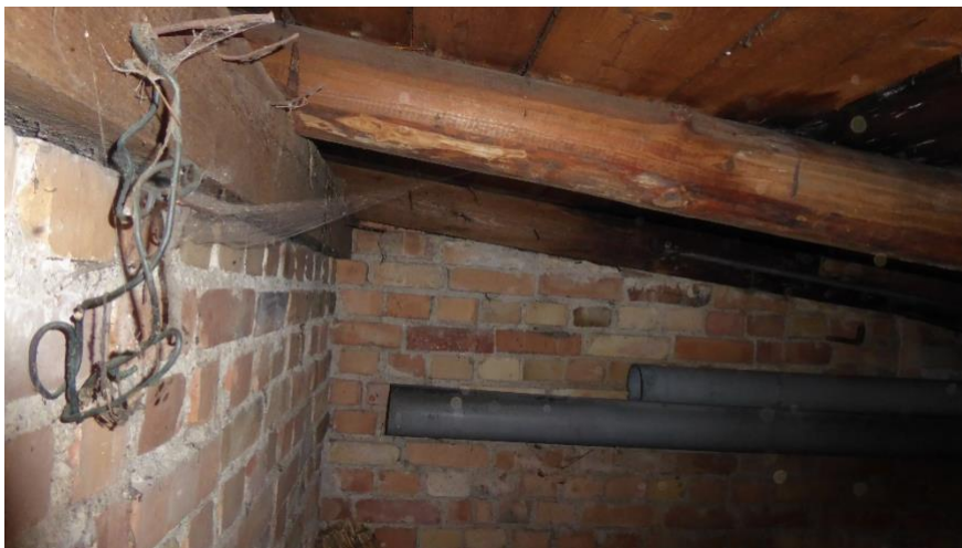
Dachbalken mit Spinnweben
