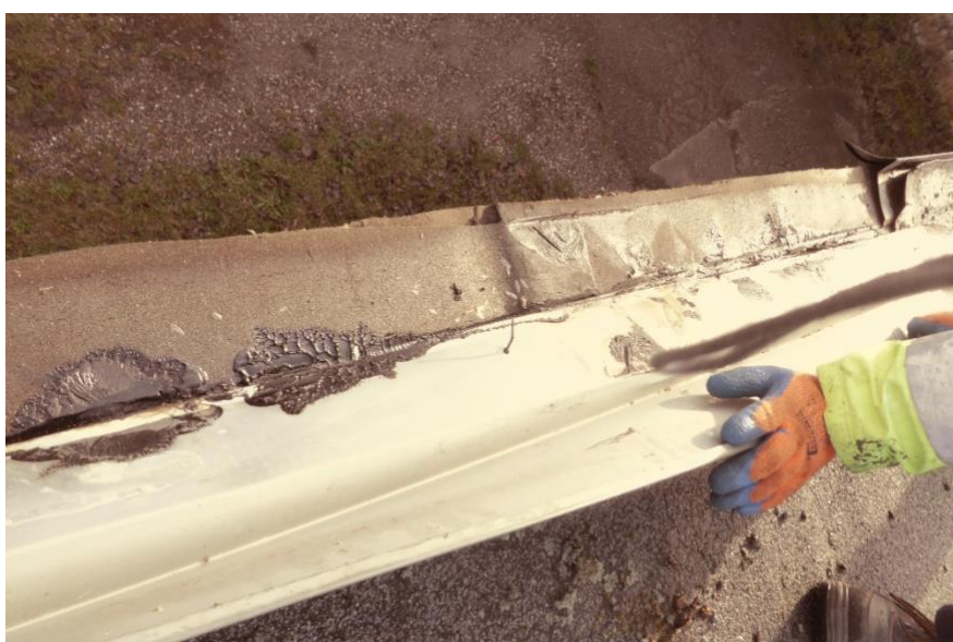
aufgebogene und anschließend entfernte Attika an der Ostseite
