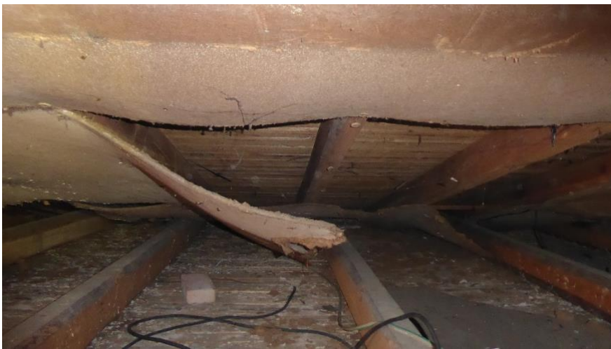
herausgebrochene Verkleidungselemen te aus Pressspan
