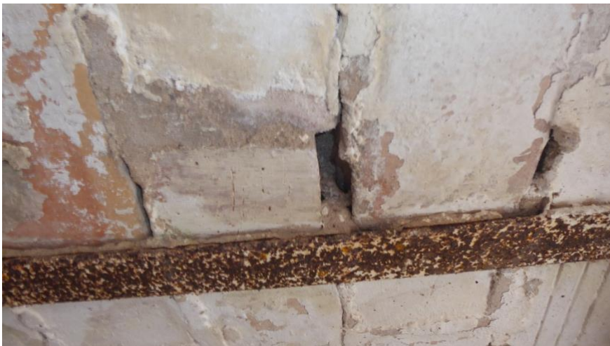
rostiger Deckenbalken, Löcher in Zwischen räumen der Hohlblocksteine
